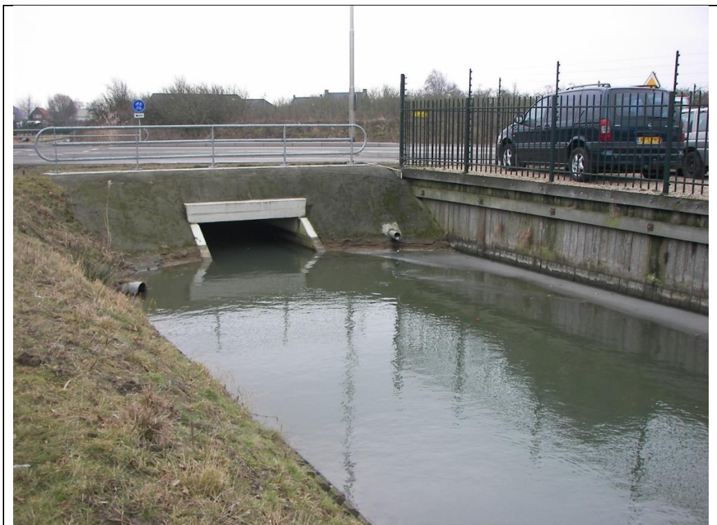
Een WACO duiker aanleggen is een goede garantie voor een optimale vismigratie. Belangrijk is ook dat er lucht boven het water in de duiker aanwezig is.
